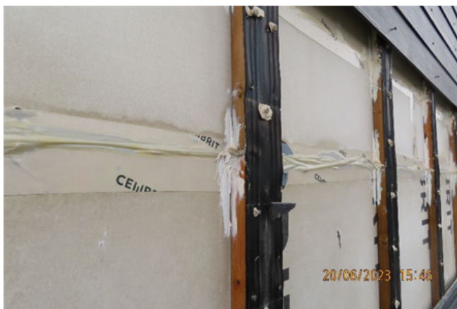
Fugning op mod afstandsliste mellem tape og liste.
